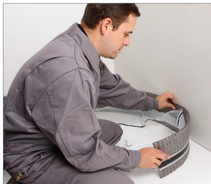
2. Instalace dilatační pásky na stěnu místnosti
