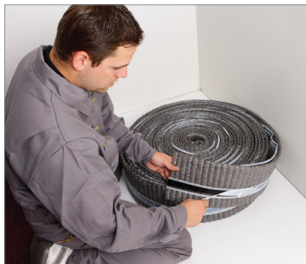
1. Oddělení ochranné pásky lepidla dilatační pásky
