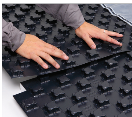
5. Instalace systémové desky na podklad
