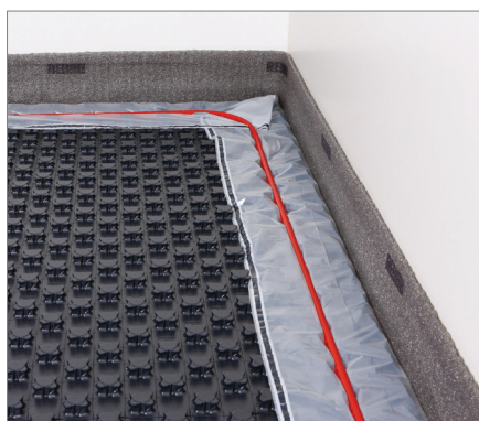
8. Detail pokládky trubky RAUTHERM S u stěny
