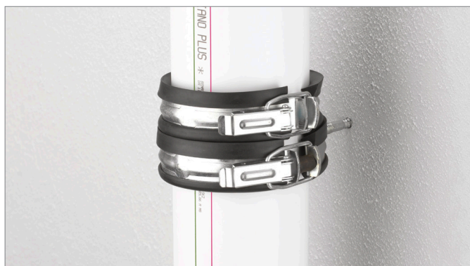
3. Hotové nainstalované podpůrné upevnění
